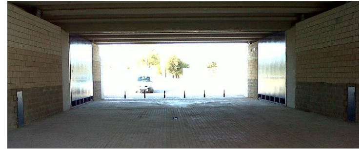
Vista de la compuerta abatible de eje vertical situada en Charco de La Pava visto desde el barrio de Triana.
