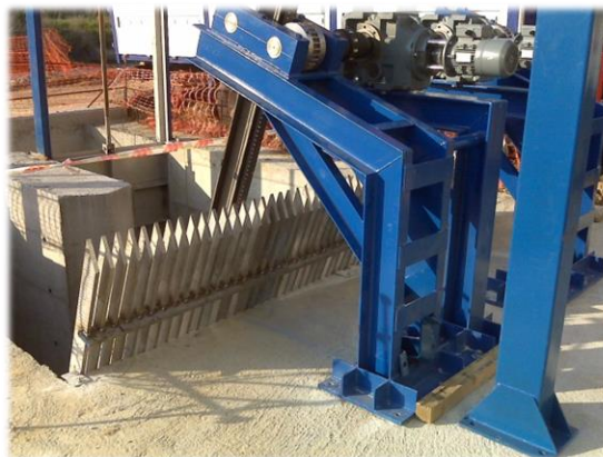
Limpiarrejas lineal en el la balsa de La Gitana. Confederación Hidrográfica del Guadalquivir.
