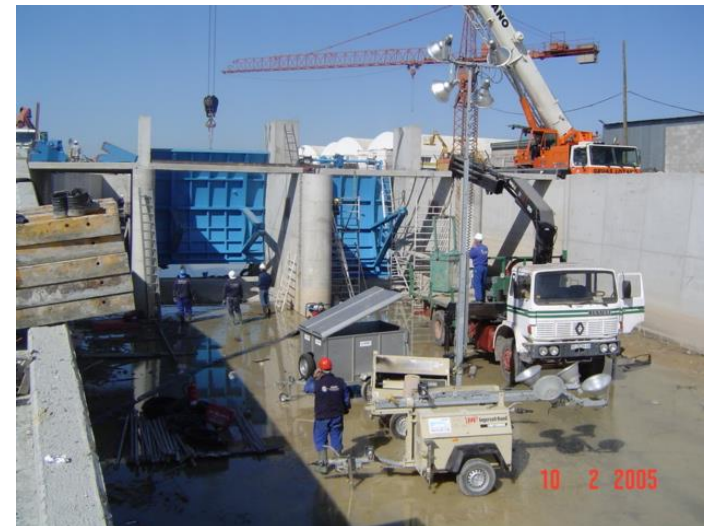
Montaje de compuertas Taintor en Torreblanca (Sevilla)
